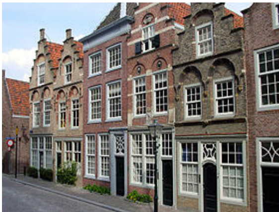
Dordtse geveltjes in de Hofstraat. Deze gevels zijn gebouwd als meesterproef van het metselaarsgilde.
